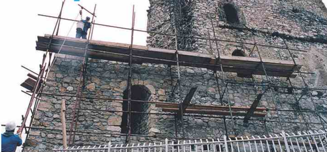
Da bo stolp kar najbolj varen, so morali pri obnovi obnoviti temelje. Sicer pa bo grad po obnovi izgledal tako, kot smo ga bili vajeni doslej. (foto: vos)
