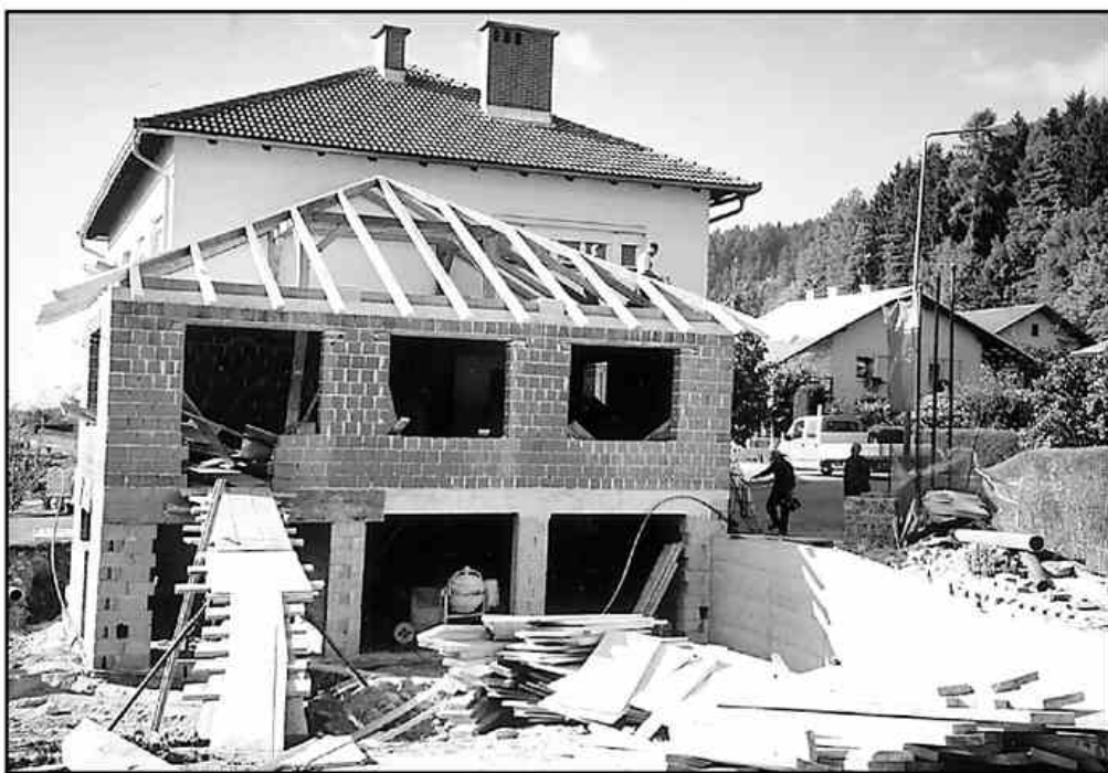
Občinska stavba je postala pretesna. Prizidek je bil zato nujen.
