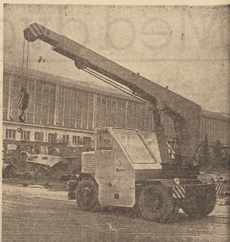
Med novimi proizvodi Litostroja je tudi prevozno dvigalo zmogljivosti 4,3 tone, ki ga bodo prihodnje leto izdelovali v maloserijski proizvodnji. — Dvigalo je bilo prvič razstavljeno na letošnjem jesenskem Zagrebškem velesejnu in je vzbujalo veliko zanimanje gospodarstvenikov v raznih industrijskih področjih
