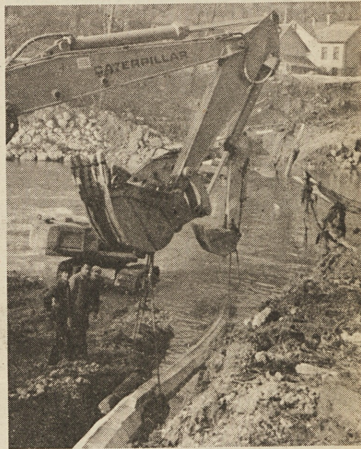
Polaganje plinovoda čez Savo. Rok izgradnje je bil kratek, toda mariborski monterji so delo opravili pravočasno.
