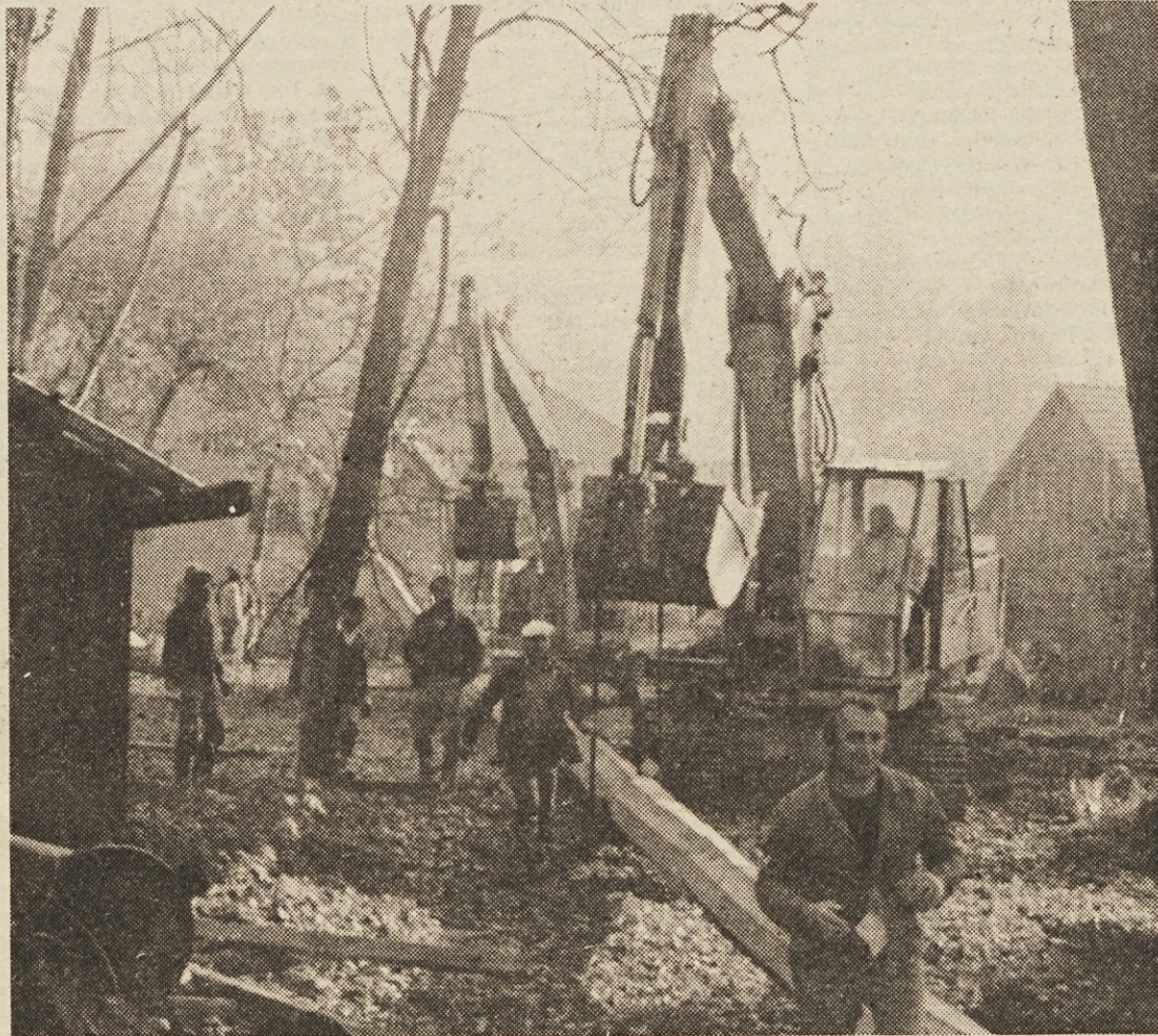
Mehanizacija je nujna za uspešno polaganje plinovoda.
