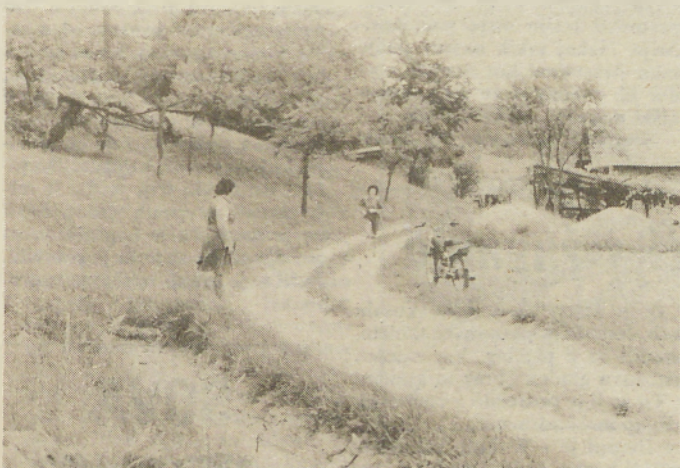
Območje, kjer so prenehali izkopavati obcestni jarek, ker tega niso do- volili lastniki zemljišč. Ob nalivih voda zdaj steče po kolniku in priteče do Sukičeve domačije. Foto: Š. S.
