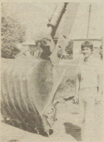
— Vodja delovišča na cesti Gederovci—Skakovci je gradbeni tehnik Anton Heric, dela pa izvaja Cestno podjetje Maribor, tozda za obnovo cest Murska Sobota.
