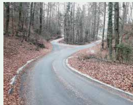
Sanacija asfalta Trojno
