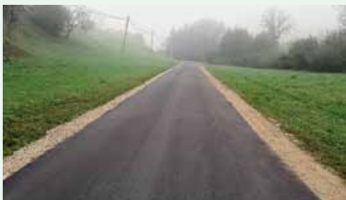
Sanacija asfalta Reka
