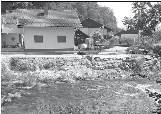
Saniran temelj in oporni zdi na Šutni (Foto: LM)
