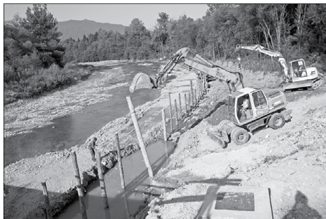
Zabijanje lesenih pilotov pod mostom na Trnovec (Foto: Marija Lebar)
