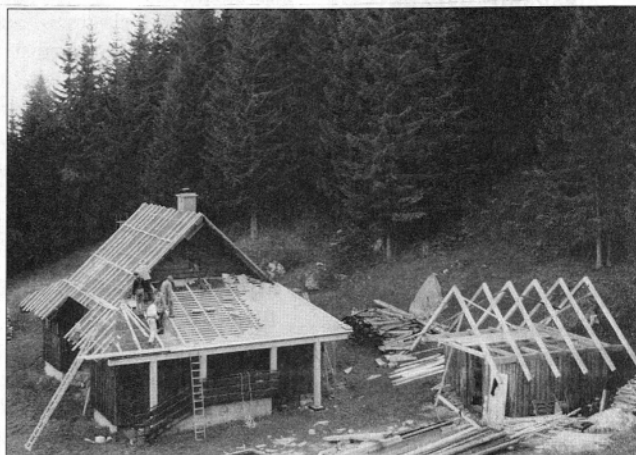
Obnova depandanse Mozirske koče in zunanosti zavetišča članov celjske postaje Gorske reševalne službe na Golteh
