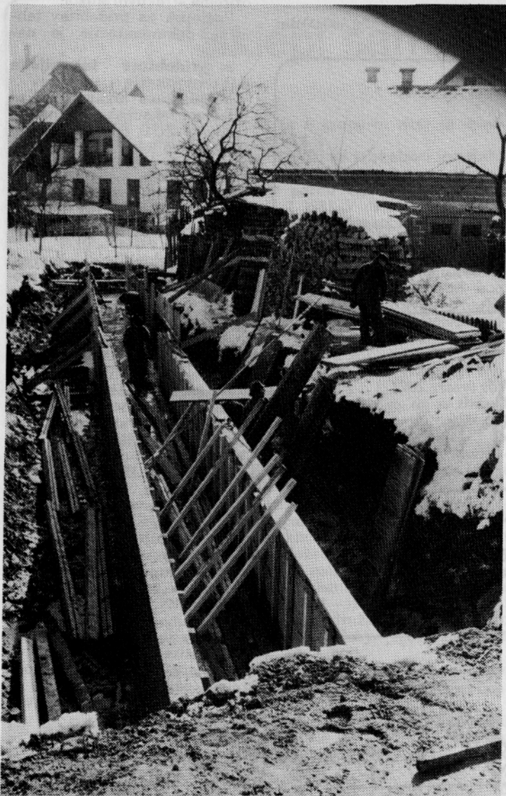
Začetek gradnje glavnega kanala za odtok vode in osušitev terena, kjer bo skladišče oblovine mehaniziranega skladišča na Rečici (foto Ažman)
