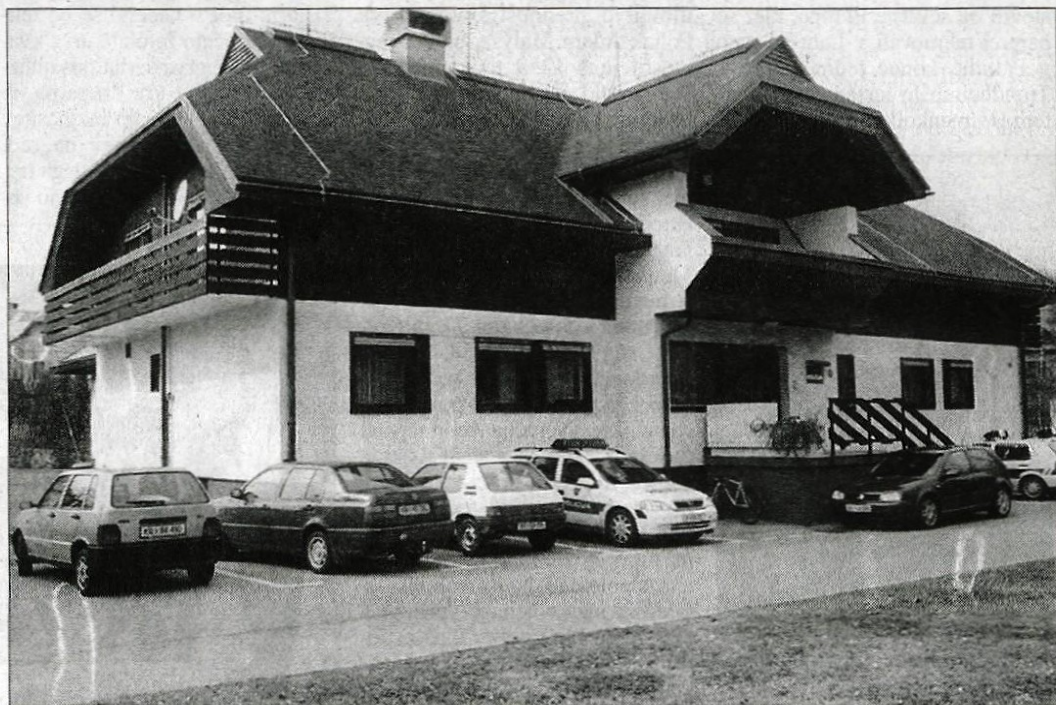
Stavba Policijskega oddelka Bled
