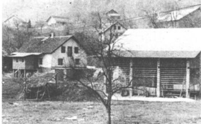
Izgradnja ceste Bevče—Salek—Gorica ter notranja ureditev doma krajanov sta prednostni nalogi za letos
