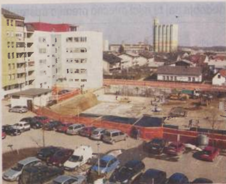
Temelji za novi stanovanjski blok so nared.
