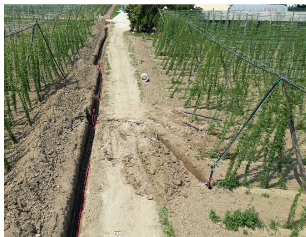
Izkopi in polaganje primarnih cevovodov ter navezave posameznih sektorjev na primarni cevovod (Foto: B. Naglič)
