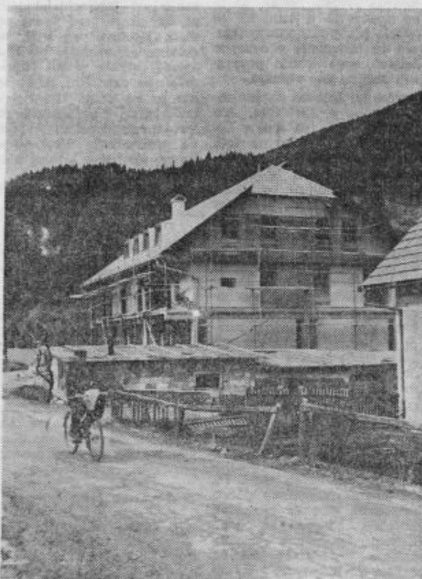
Se nekaj tednov trdega dela in prvi blok v Lučah ob Savinji bo končan. V pritličju zgradbe bo dobila prostore samopostrežna trgovina, vrhni prostori pa so namenjeni stanovanjem. (Foto: Berni)
