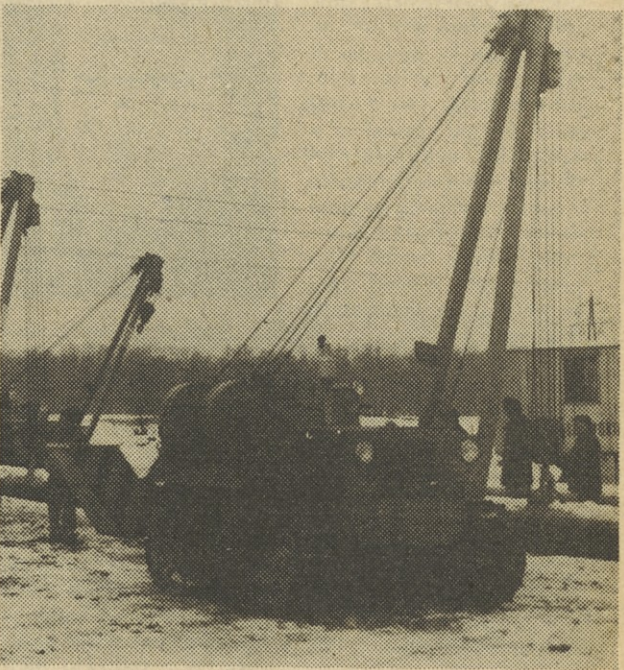
Buldožerje — prirejene za dvigovanje bremen so izdelali v 14. oktobru iz Kruševca
