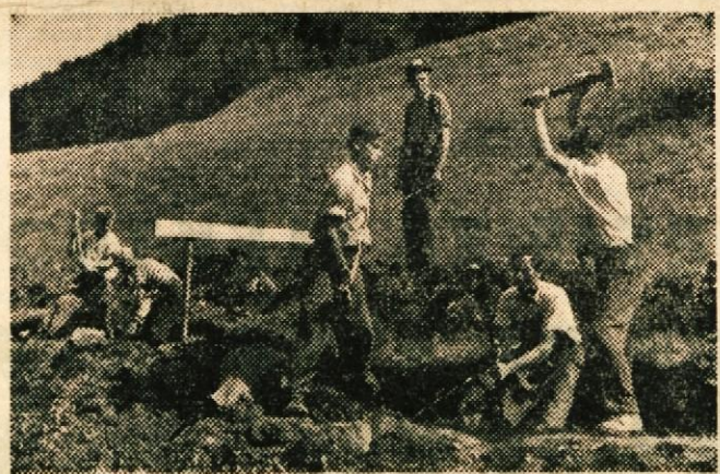
Nad 1000 metrov jarka za novi vodovod so že izkopali
