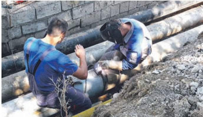
Varjenje cevovoda na 3 cevnem distribucijskem sistemu
