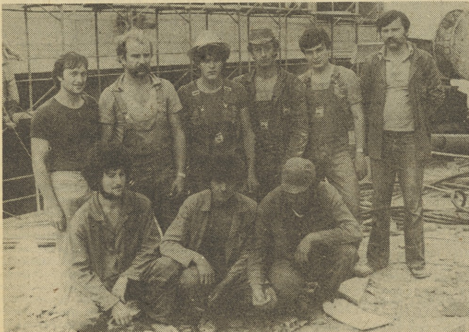
Skupina delavcev na gradbišču Osnovne šole v Semeđeli pri Kopru. Od leve proti desni Cveto Tavčar, Vlado Turk, Darko Potrebuješ, Vinko Habjan, Dušan Strnad, Leopold Novak. Spreddaj so monterji Učičani. Od leve proti desni Milanko Mladenović, Milenko Mandić, Milisav Bijelić.
