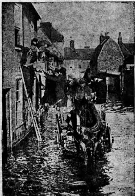
Ob priliki zadnje poplave na Angleškem je bilo najtežje prizadeto mesto Canterbury. Naša slika kaže rešena dela v poplavljenem mestu.
