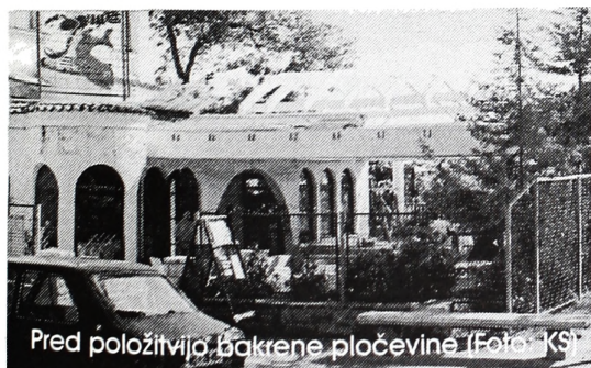
Pred položitvijo bakrene pločevine (Foto: KS)
