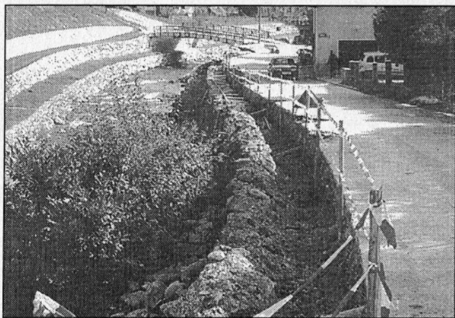
Začetek gradnje nove ograje na Petkovem klancu oktobra letos (foto: ToP)
