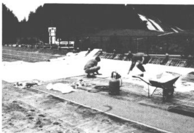
Prenova strehe naj bi veljala 19 mio tolarjev, delo pa so opravili delavci podjetja ESO KIKO iz Šoštanja
