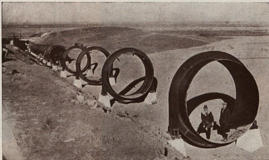
Kako nameščajo več tisoč ton jekla pod zemljo za novo namakalno napravo v Platte Valleyu v Nebraski.
