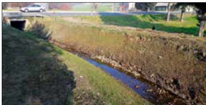
Čiščenje potoka Bobot v Obrežu od mostu na državni cesti do mostu na Grabah
