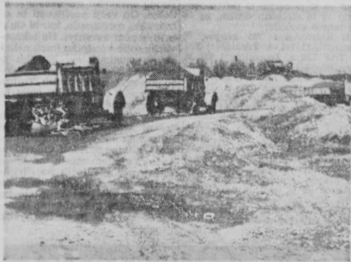
Na gradbišču SDI
