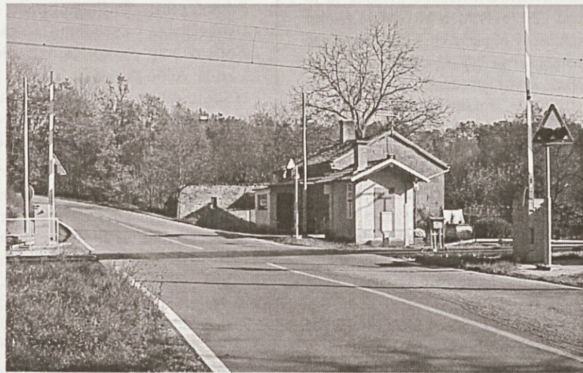
Prehod čez železnico in hiša št.1
