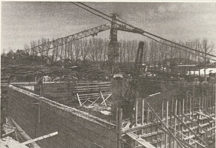
Zaradi dolge zime in zaradi neugodnega terena, gradnja skladišča gotovih izdelkov v Medvodah počasi napreduje
