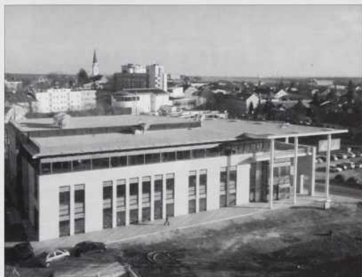
Pogled na novo, še ne povsem urejeno poslopje Pokrajinske in študijske knjižnice v Murski Soboti, kjer bomo kmalu izbirali med 270 tisoč knjižnimi enotami in 500 periodičnimi publikacijami. Zdaj je odprt študijski oddelek, knjige iz splošnega oddelka v gradu pa so že začeli preseljevati v nove prostore.
