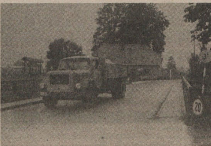
Dela na mostu čez Mali graben
