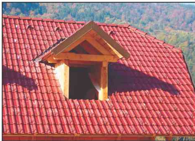
Že sama konstrukcija frčade (kukerla) je precej draga. Na koncu pa moramo kupiti tudi okno, ki pa zaradi konstrukcije osvetli prostor do 30% manj.
