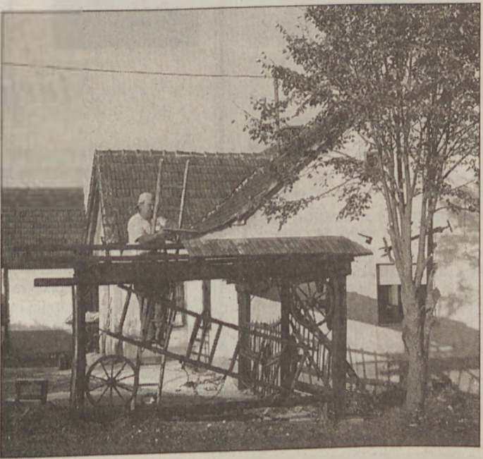
Očetnjava ne sme propasti, je sklenil Štefan Matuš, ki živi v Postojni, in začel obnavljati rojstno hišo v Dolencih. Še več: orodje, ki ga ne
