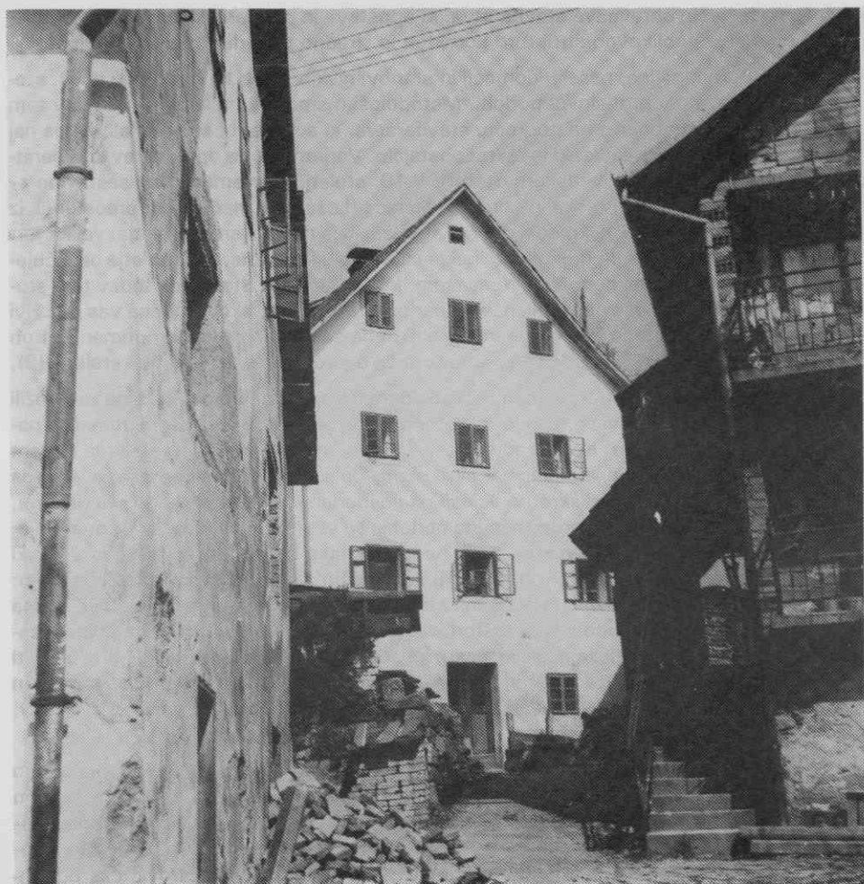
5) IDRIJA. Hiša v Rožni ulici. Večstanovanjska hiša z omeženo in beljeno fasado iz 19. stoletja, o čemer pričajo proporcije in dimenzije oken in vhoda. Kletni in pritlični del sta zidana, višji nivoji so izvedeni v preprosti skeletni konstrukciji (polnilo sta kamen in slabša opeka).
