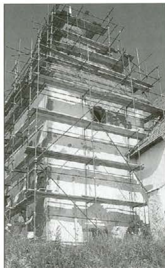
Pričela so se obnovitvena dela na zvoniku najvišje po nadmorski višini postavljene cerkve v Sloveniji na Uršlji gori - za strešno kritino bo potreben macesnov les
