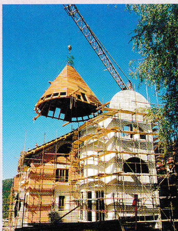
Prva faza obnove – preureditev obstoječih stavb in vhod
