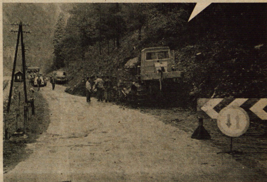
Kranjsko Cestno podjetje je pred dnevi začelo urejati kilometer dolg odsek ceste v Bohinju od železniške postaje Soteska do mostu čez železniško progo v Soteski. Cesto bodo razširili na 6,5 do 7 metrov in ublažili nekatere ovinke; mostu čez Savo Bohinjko pa ne bodo širili. Denar za ta dela je zagotovila republiška skupnost za ceste. — Foto: A. Zalar
