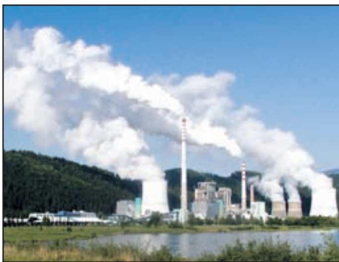
Sedanji vir proizvodnje toplotne energije - Termoelektrarna Šoštanj
