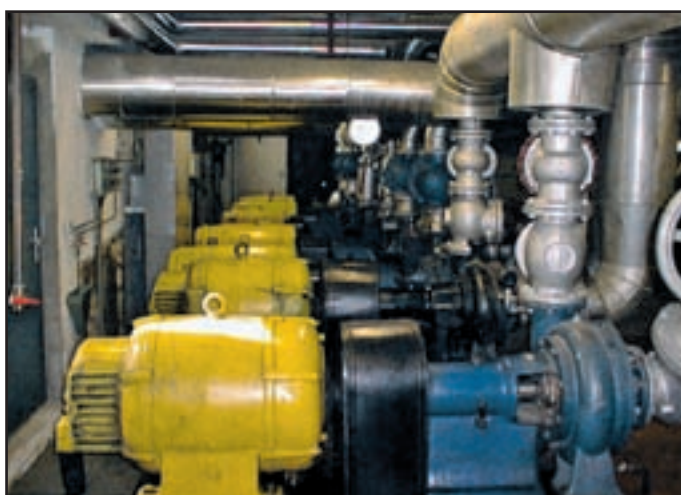
Centralna energetska postaja zgrajena v začetku 70. let prejšnjega stoletja, fizično odstranjena 2007 zaradi izgradnje nove
