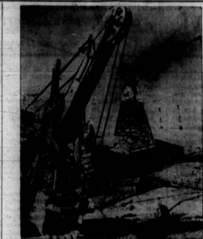
Električna lopata, katero rabijo pri gradnji jeza Shasta v Californiji.
