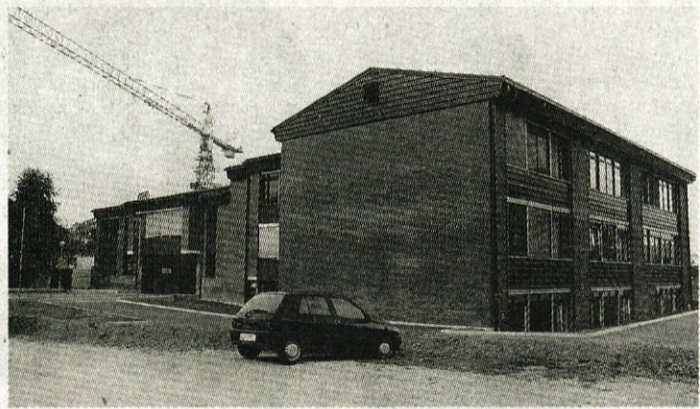
Pred letom dni je bila na severu šole še gradbena jama, danes pa tu že stoji prizidek z devetimi učilnicami.
