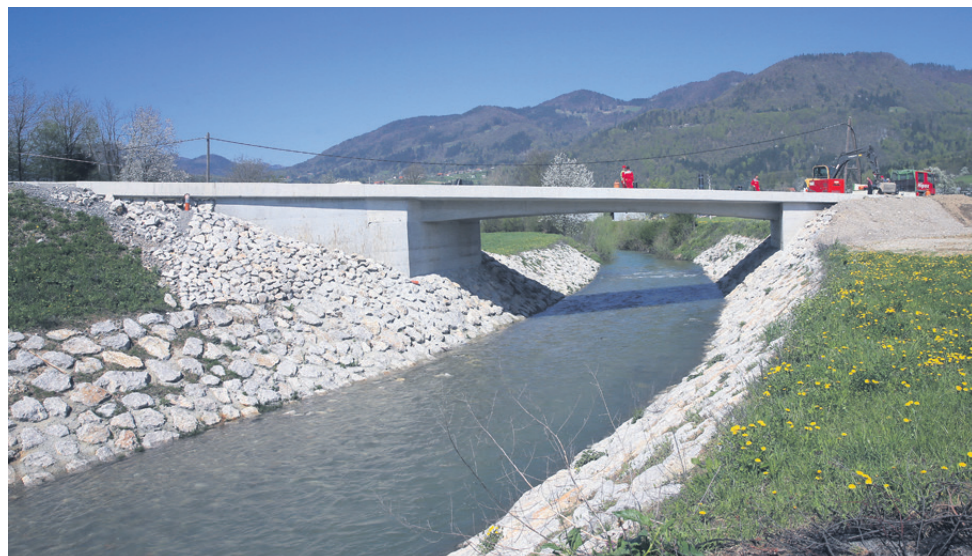
Gradnja mostu čez Bolsko, ki je ob zrušitvi pred štirimi leti zahteval dve mladi življenji, je končana. Za promet bo odprt po pridobitvi gradbenega dovoljenja.
