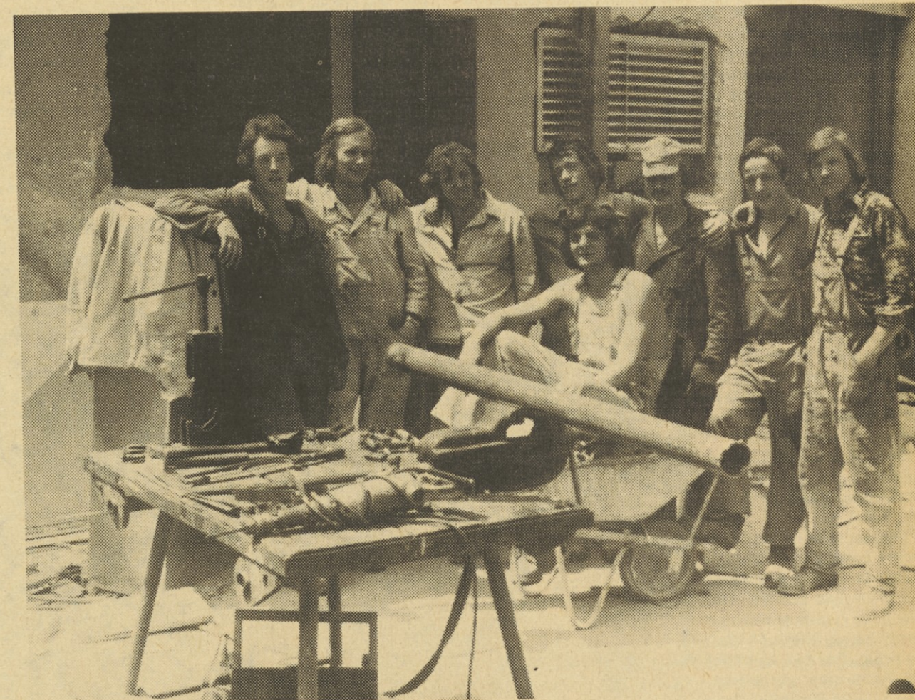
Skupina naših monterjev na gradbišču v Poreču
