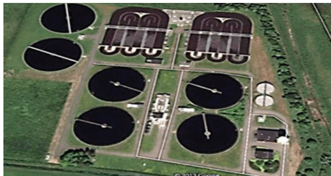
Ko se je pojavila okvara reduktorja na enem od aeratorjev v aeracijskem bazenu, so se odločili za zmanjšanje porabe energije na č. n. in prepolovili prostornino zgrajenega aeracijskega bazena (slika 20) in s tem v napravi opustili denitrifikacijo, za katero je bila zgrajena. Namesto načrtovane male HE (3.000 kW) pa so zgradili gnilišča za bioplinarno z
