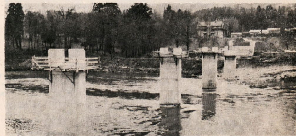
Stebri za moste čez Savo v Radečah so gotovi, sledi gradnja nosilne konstrukcije
