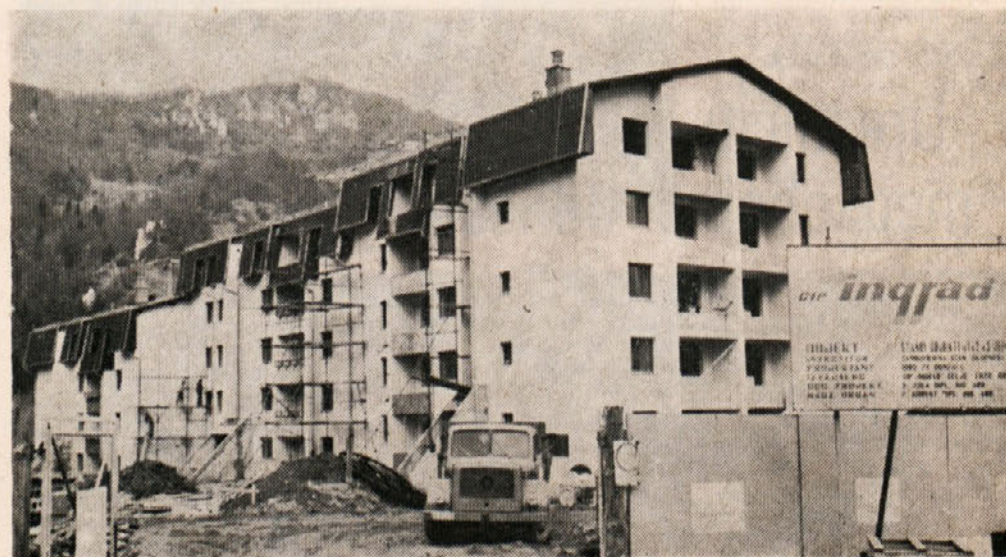
Stanovanjski blok v Radečah v zaključni fazi izgradnje
