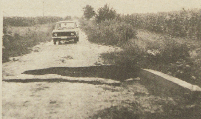
V poletnih dneh je bilo v naši pokrajini veliko dežja, zato so narasle vode ponekod predrle nasipe in porušile dotrajane mostove. Tafe posnetek prikazuje, kako je narasla voda uničila nov most na melioracijskem kanalu pri Kobilju.
