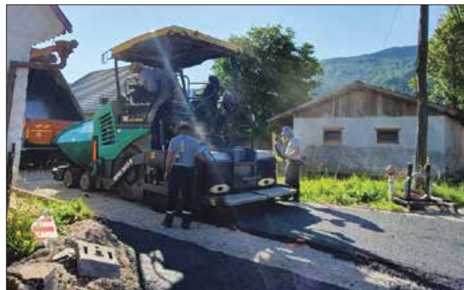
Nov asfalt kot zaključek dvoletnega projekta v Pustem Polju (fotodokumentacija Občine Nazarje)
