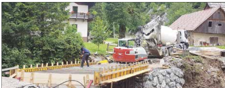
Dotrajan most »Žohar« v Logarski dolini je bil v sodelovanju z ministrstvom za obrambo deležen temeljite sanacije.
