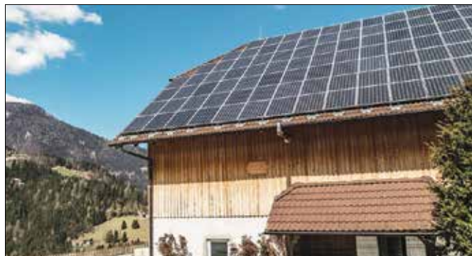
V okviru Energetske skupnosti Luče so namestili za 102 kW sončnih elektrarn na devetih objektih.
