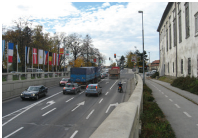
Slika 3 • Levo – Neprimerno postavljena signalizacija ne zagotavlja zaznavanja; desno – usmerjevalni pasovi brez predhodne informacije za voznika o razvrščanju in smereh.
