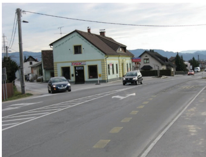
Slika 4 • Levo – Nezadostna preglednost v križišču; desno – Neprimerno vodenje levih zavijalcev na glavni prometni smeri.
