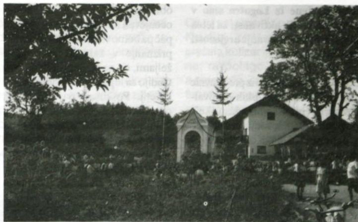
V srcu Blekove Vasi: obnovljena kapelica. Foto: A. Ž.
