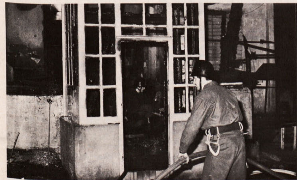
Krožek Zvezda v Podlonjerju. To je vse, kar je ostalo po požaru
