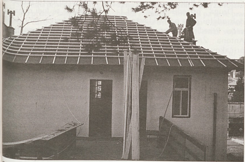
Obnova v požaru poškodovane stanovanjske hiše na Bazoviški 10 v Ilirski Bistrici je že v teku.
