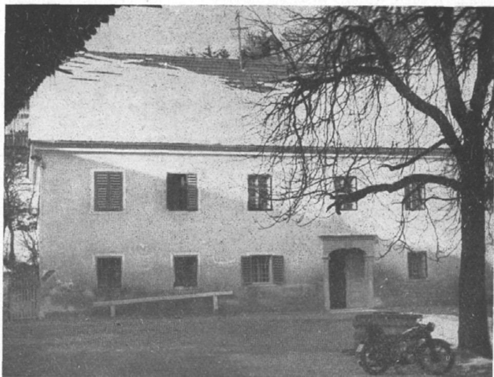
Kovačeva hiša v Krtini pri Domžalah. V njej je delovala nekaj časa moravska tehnika.
