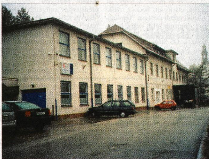
Prostori v nekdanjem objektu kranjske Planike na Breznici so deloma že oddani, bodoči kupci drugega dela pa zahtevajo okoli stavbe dovolj parkirišč.
